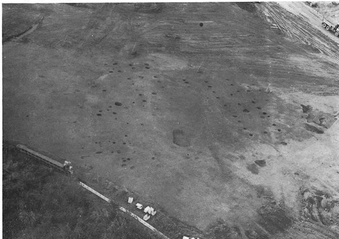
(1) 都地遺跡掘立柱建物群 (南東から)
